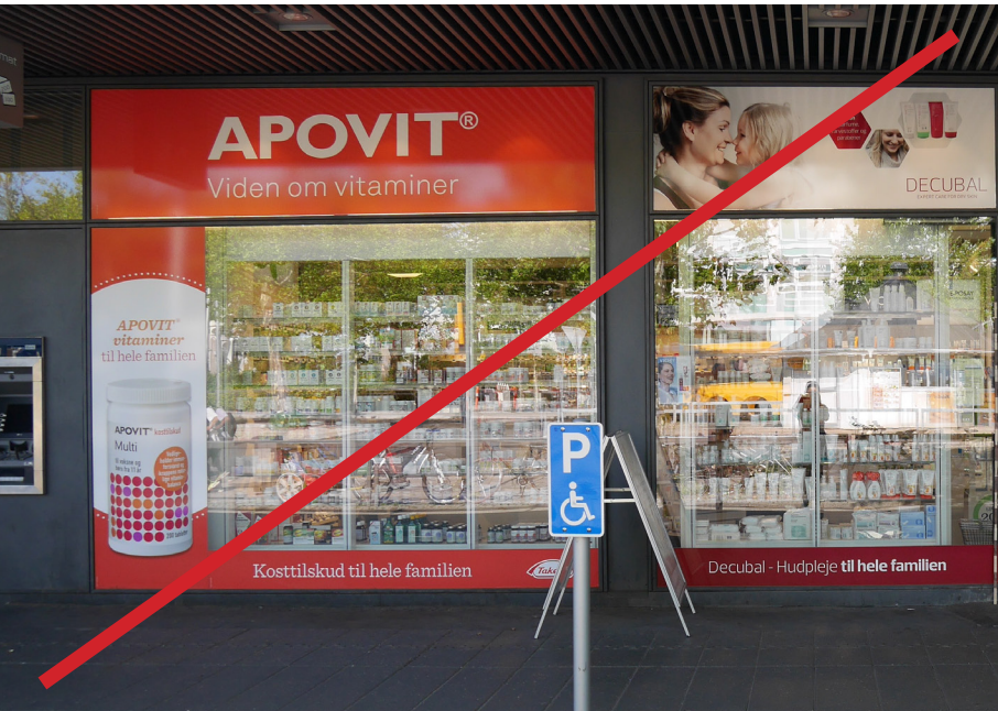
Facade indhyldet i reklamefolie forstyrrer skiltningen og virker anmasende.
